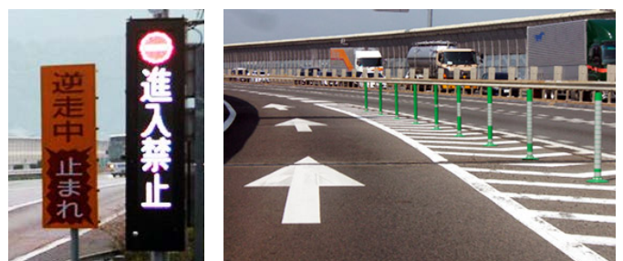
逆走防止装置 矢印路面標示・ポストコーン
