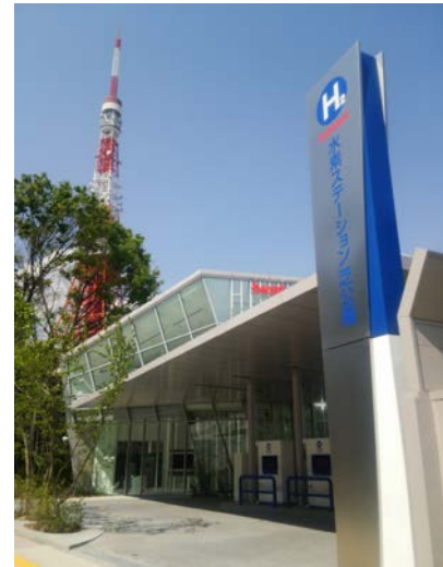
燃料電池自動車用水素ステーション
